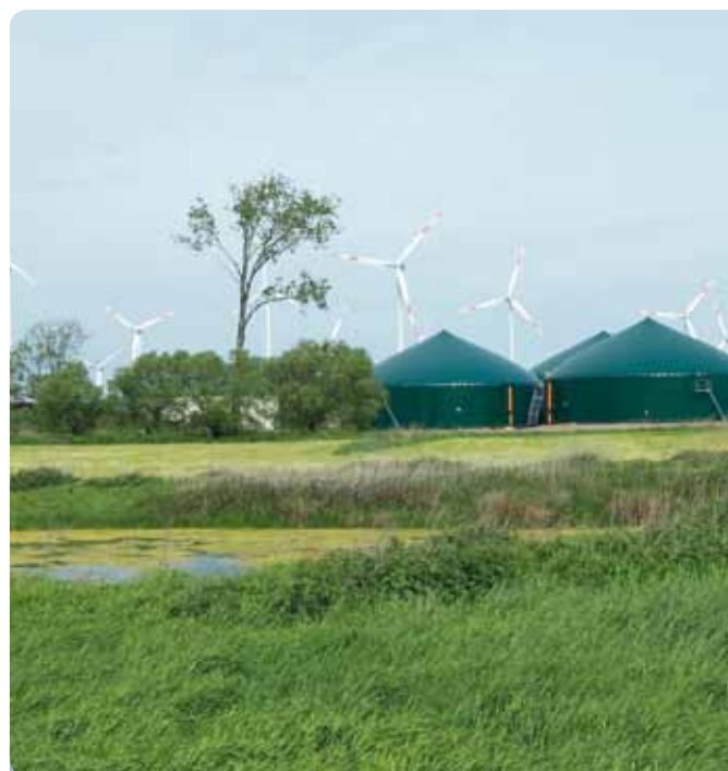
Die grüne Zukunft ist hier: Unter den Hauben der Biogasanlagen gären die zugeführten Substrate.
