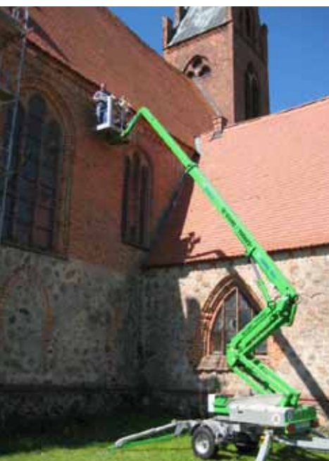
Per Schere oder Teleskop: Schnell und sicher ist der Arbeitsplatz in luftiger Höhe erreicht.
