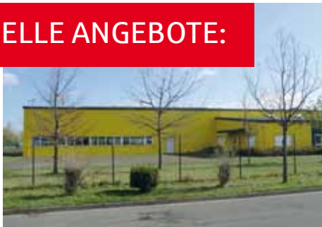
Stahlträgerhalle in Falkenhagen
