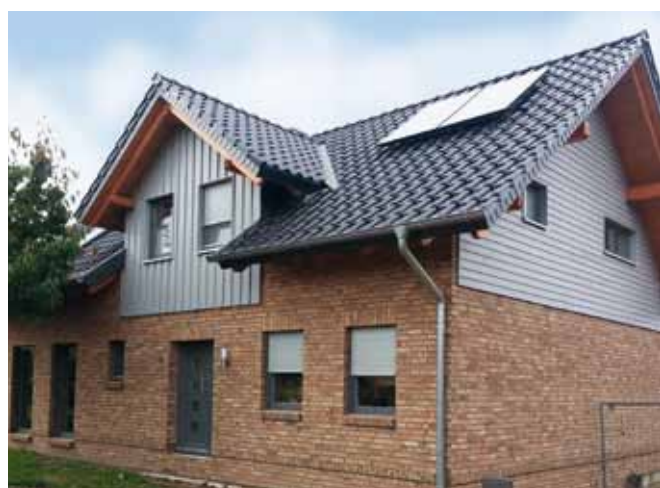
Oben: Fachwerkhaus in Putlitz, Fachwerkaufbau unter Verwendung historischer Baumaterialien in traditioneller Bauweise
